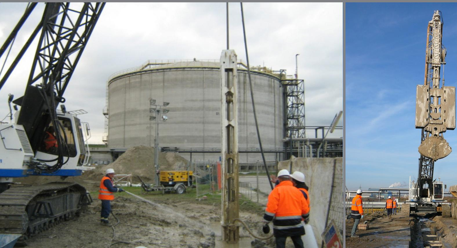
contenimento dei serbatoi di MtBE (metil-t-butil-etere, un composto chimico impiegato come antidetonante al posto del piombo-tetraetile e degli altri additivi a base di piombo nelle benzine, per questo dette senza piombo) e metanolo e della strada ad esso adiacente. Inoltre era compresa la rimozione dei terreni contaminati residui mediante escavazione fino a profondità massima di 33,0 m da p.c.
